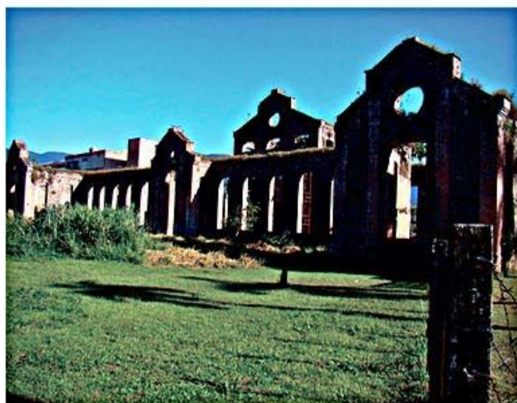
Ruínas do Engenho Central de Bracuhy: As ruínas são cercadas por vegetação típica de manguezal. Já foi o mais moderno engenho do Brasil, com maquinários vindos da Europa. Construído na mesma área da Fazenda Bracuhy, tem fossos subterrâneos e paredes bem espessas. Sua arquitetura, apesar de estar em ruínas, ainda guarda os traços da Revolução Industrial.
