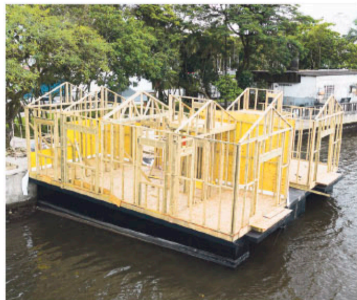
Protótipo da casa está sendo construído no Jardim Casqueiro
